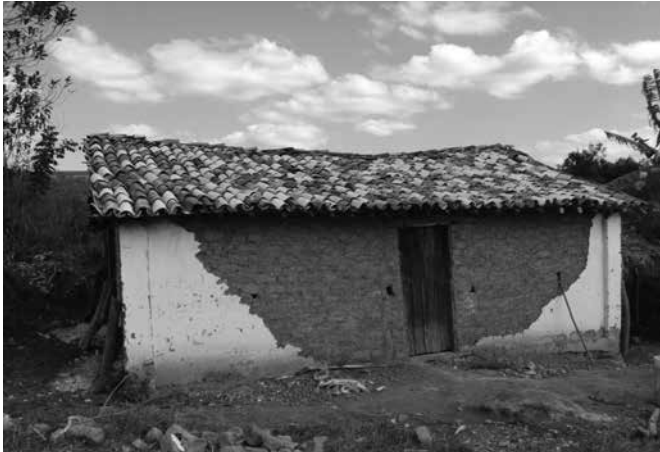
Figura 4: Telhas de casa de farinha construídas artesanalmente com barro na coxa de camponeses. Comunidade do Quilombo, município de Minas Novas, Vale do Jequitinhonha/MG. Autor: DINIZ, R. F. 2010.
