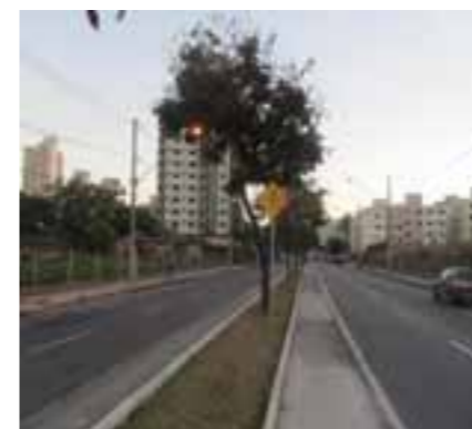
Córrego Tijuco canalizado situado abaixo da Av. Fleming o. Daniela Vieira, 2013.
