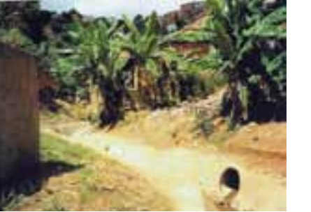
Córrego Coqueiral com canalização. Acervo Projeto Manuelzão
